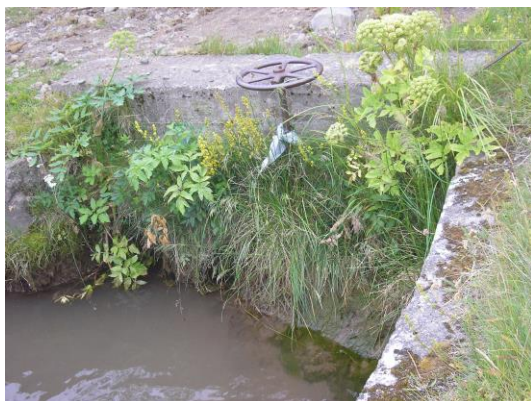
Mynd. Nr. 13 og 14 vatnsintakið fyrir og eftir hreinsun gróðurs
