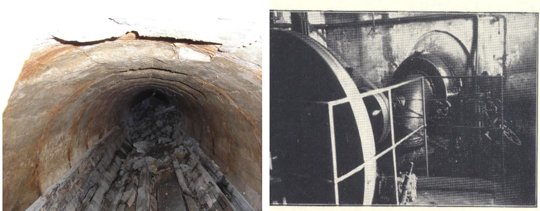
Mynd nr. 5 vatnstokkurinn sem lá frá hverfihjólinu Mynd nr. 6 Vatnstúrbínan og kasthjólíð.
