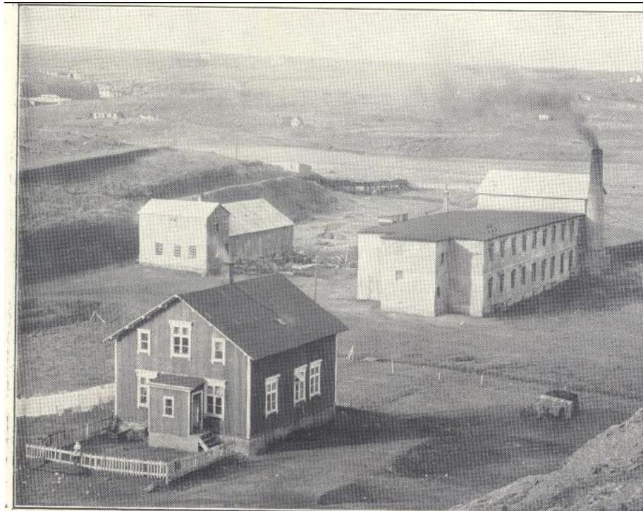
Mynd nr. 3 Úr minnigatriti verksmiðjufélagsins 1923
