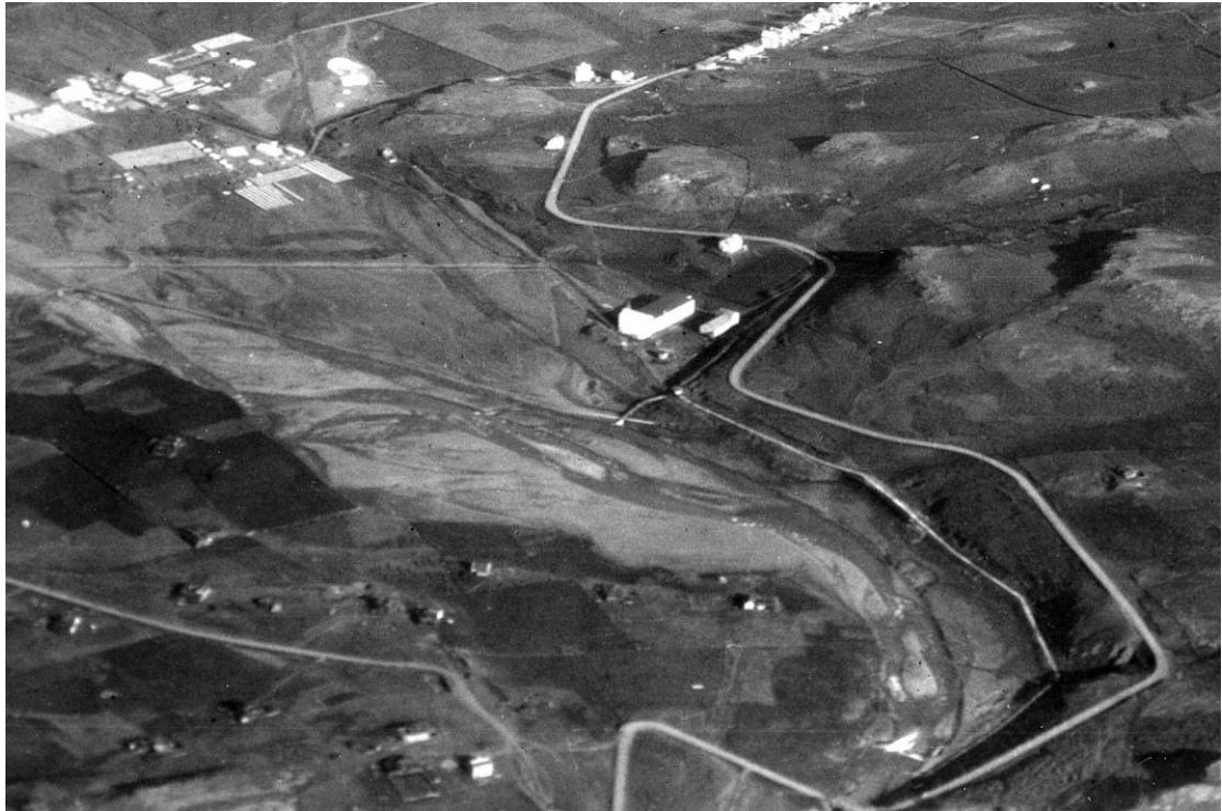
Mynd nr. 16 Vigfús Sigurgeirsson/Minjasafnið á Akureyri á myndinni má sjá legu stokksins frá stíflu og að verksmiðjuhúsunum einnig vatnsmiðlunarhúsið og affallsstokkinn.
